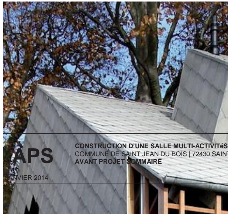
1. couverture et bardage en ardoises
