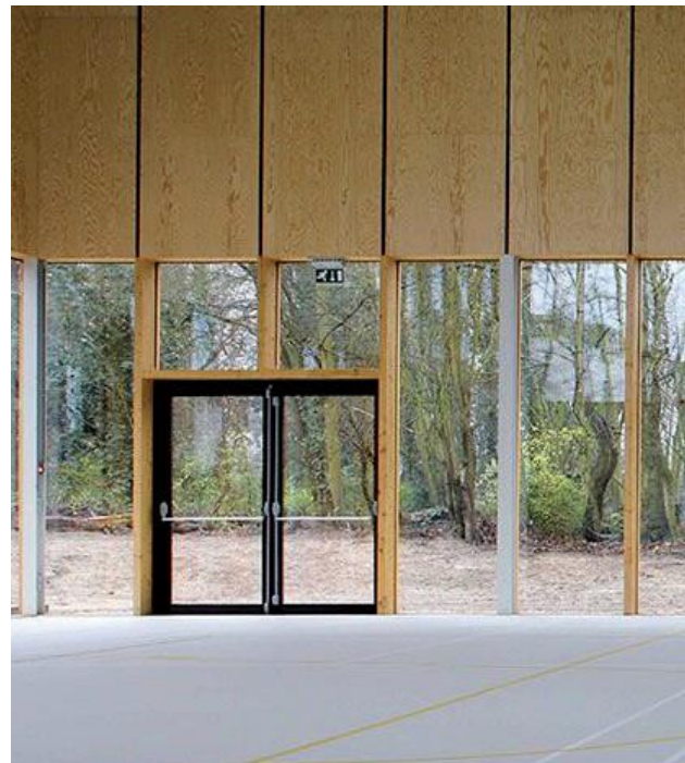
2. Structure poteaux-poutres régulière, ouverte sur le
